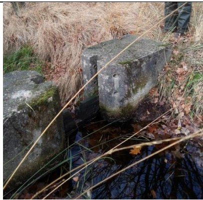
Figuur 40 Sluisje De Nol (KHN1), kijkrichting stroomafwaarts (29-nov-2012)
